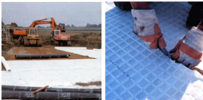
Combigrid® режется обычным инструментом
